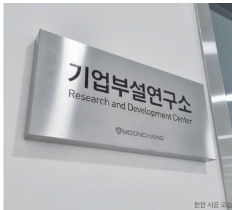
현판 시공 모습
