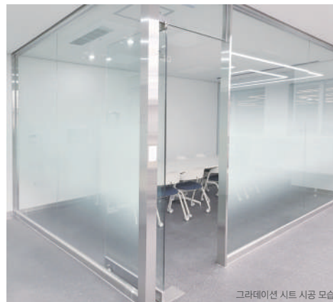
그라데이션 시트 시공 모습
